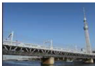
図7 東武鉄道 隅田川橋梁
