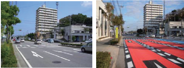
対策前 対策後 写真1 カラー舗装対策前後の状態 (主) 岡崎環状線 竜美台2交差点
